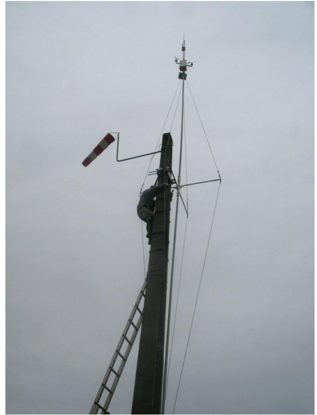
Licques, nouvelle manche à air sur roulements à billes, girouette graissée !
